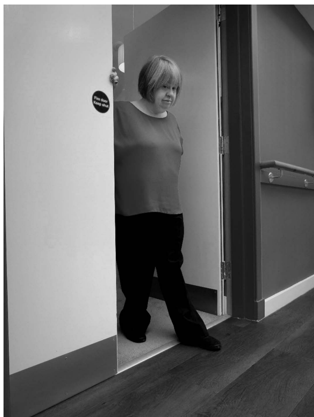
FIGURA 6. Pisos de colores diferentes en cuartos adyacentes pueden confundirse con escalones y provocar confusión.
